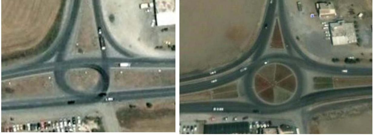
Resim 1: Değirmenlik-Girne Dağ Yolu Kavşağı: Soldaki resim, Bölünmüş Yol yapılırken uygulanan adalı sistem..Sağda ki resim ise ,adalı sistemin ülkemiz koşullarına uygun bir çözüm olmadığı belli olunca yerine alttaki Klasik Çember uygulaması yapıldı..
