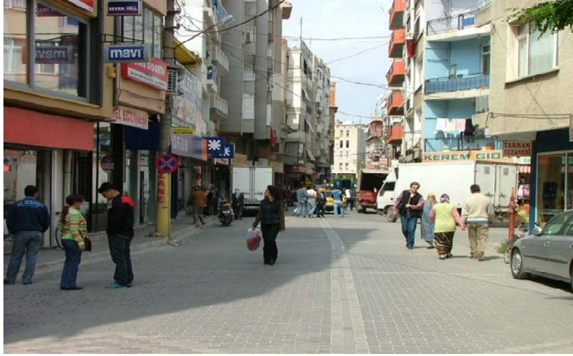
Şekil 3 Araçların kullanımı amacıyla genişletilen yol ve daraltılan kaldırımlar.
