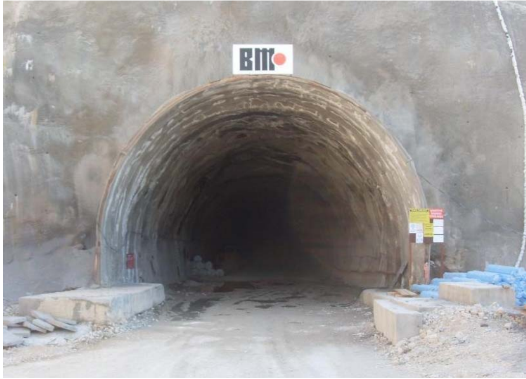
Resim 3. Karaman-Ermenek barajı geçiş yolu karayolu tüneline ise 35.000m 2 uygulama gerçekleştirilmiştir.
