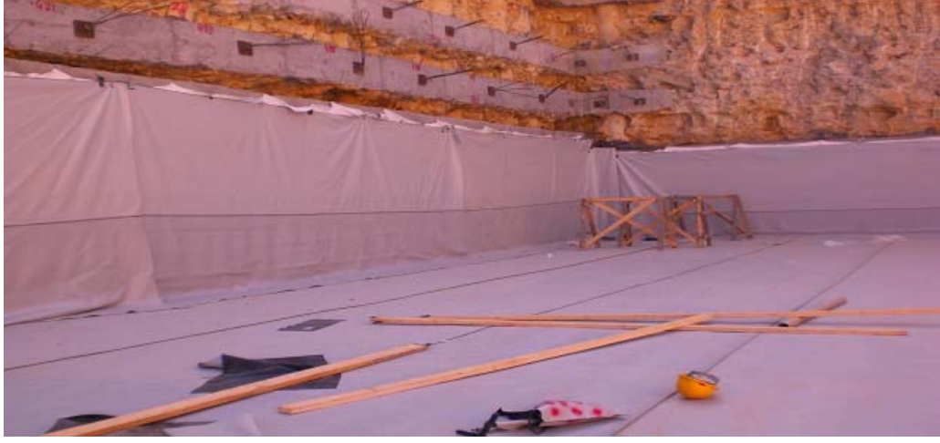
Resim 4. İstanbul Büyükşehir Belediyesi Güney sanayi metro istasyonu bohçalama 390.000m 2 'lik uygulamadan bir görüntü
