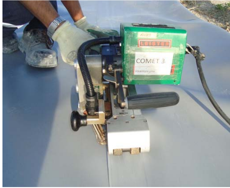
Resim 6. Kaynak Robotu ile 2 ayrı parça geomembranın kaynatılması
