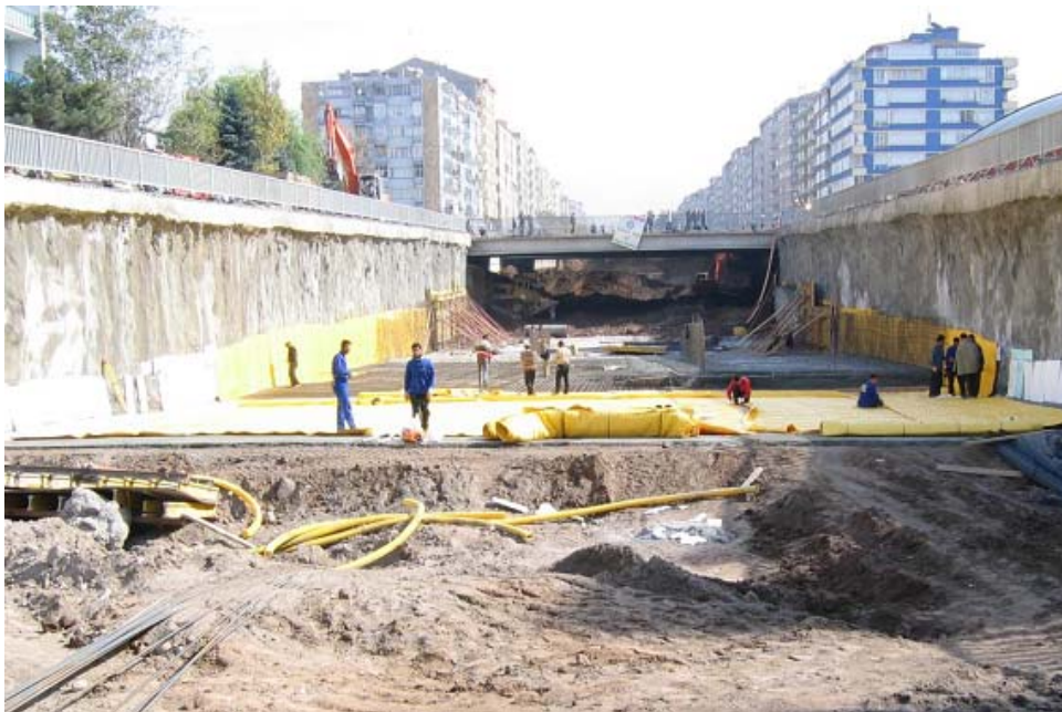
Resim 5. Kayseri Büyükşehir Belediyesi köprülü kavşak izolasyonu 30.000m 2
